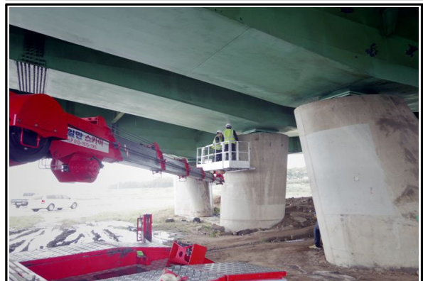
고소차를 이용한 하부비파괴 시험
